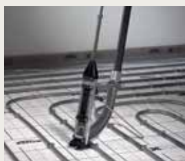
Clips per tubo precaricate.
